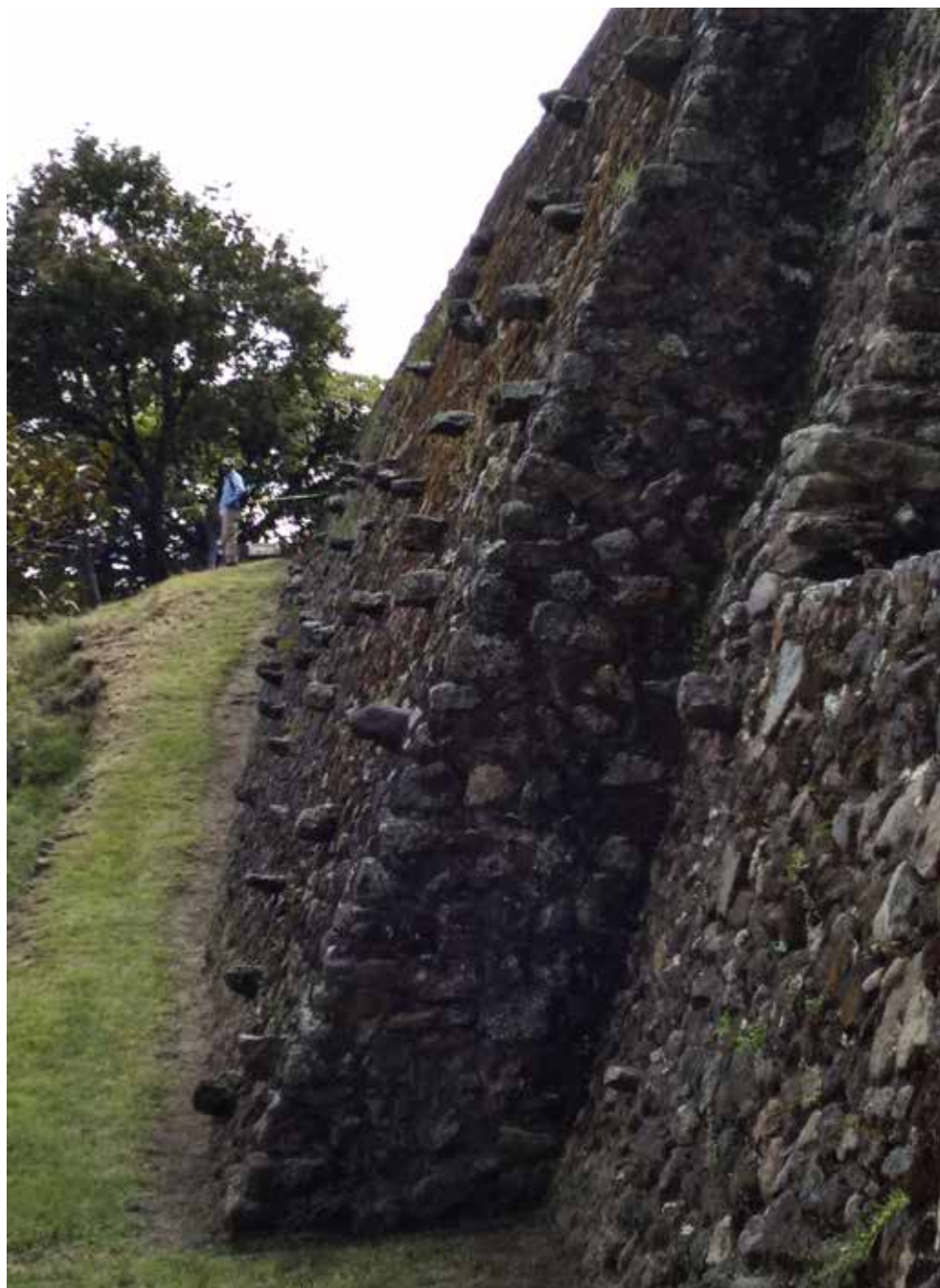
Los muros de contención sostienen las plataformas donde se edificaron los templos. Fotografía de Rubén Nieto Hernández.
